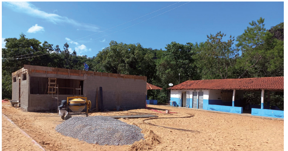
Obra do balneário
