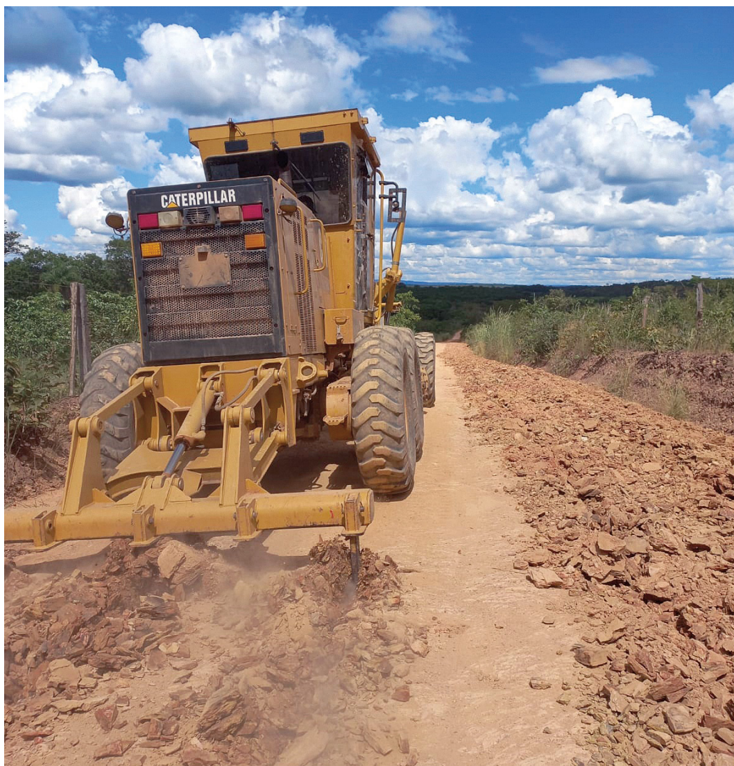
Manutenção constantes nas estradas vicinais do município
