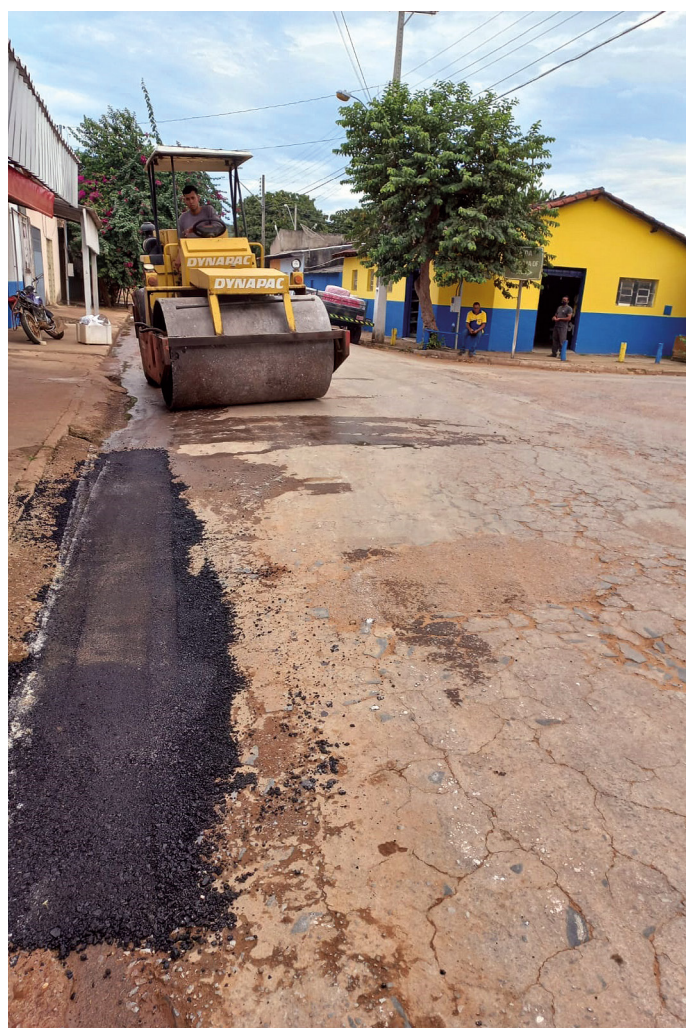
Recuperação da malha viária de várias ruas e avenidas
