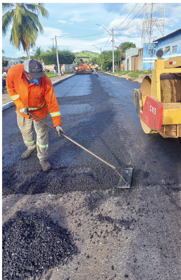
Pavimentação de ruas com CBOq
